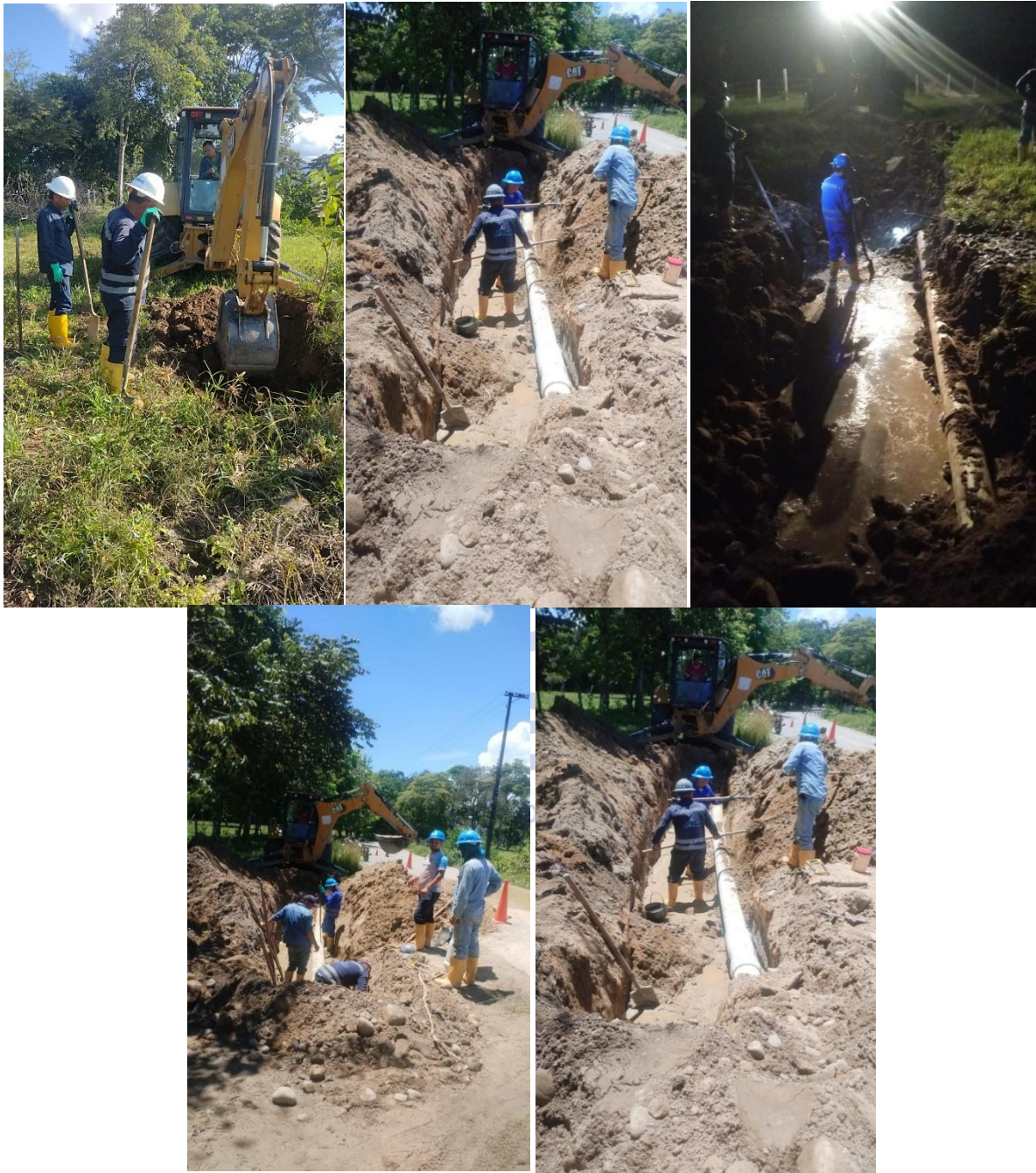
Reparaciones de tubería de conducción
