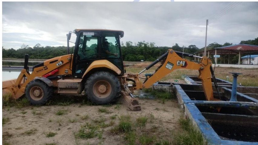
Extracción de arenas de los tanques desarenadores.
