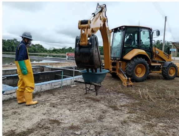
Extracción de arenas de los tanques desarenadores
