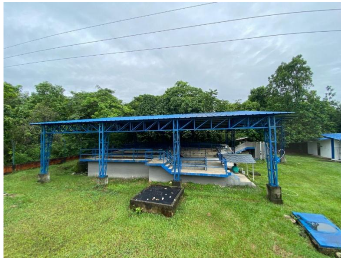
Ubicación de la Planta de Tratamiento de Agua Potable
