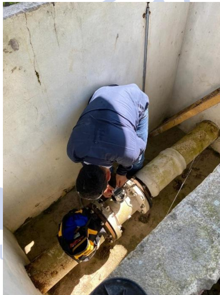
Mantenimiento a los macromedidores
