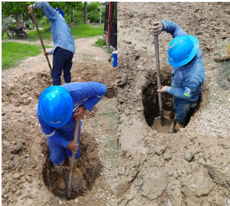
Reparación de fugas
