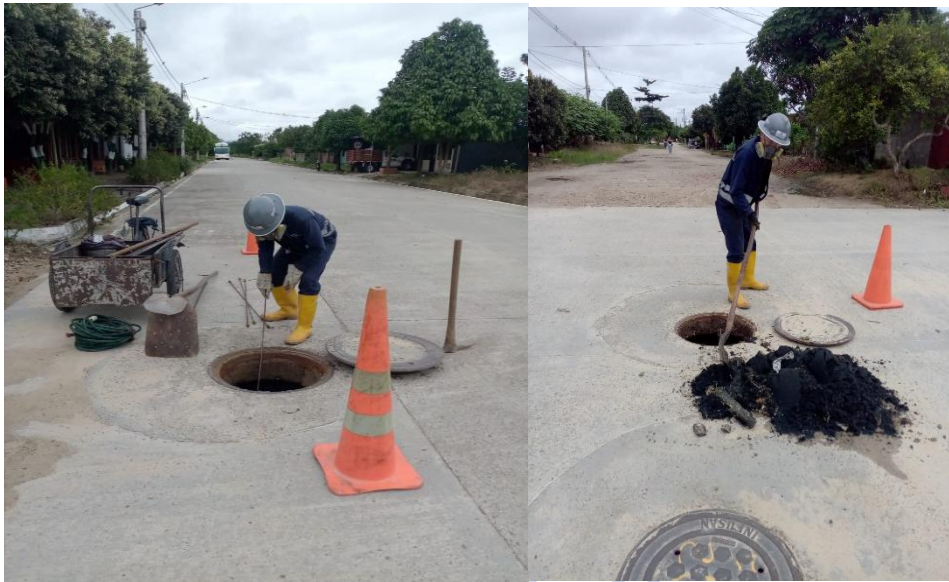
Limpieza y mantenimiento de las redes de alcantarillado
