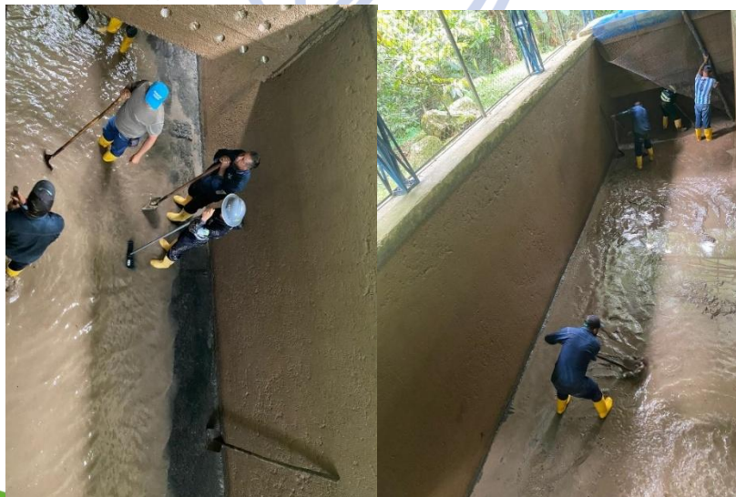
Mantenimiento y limpieza de los desarenadores
