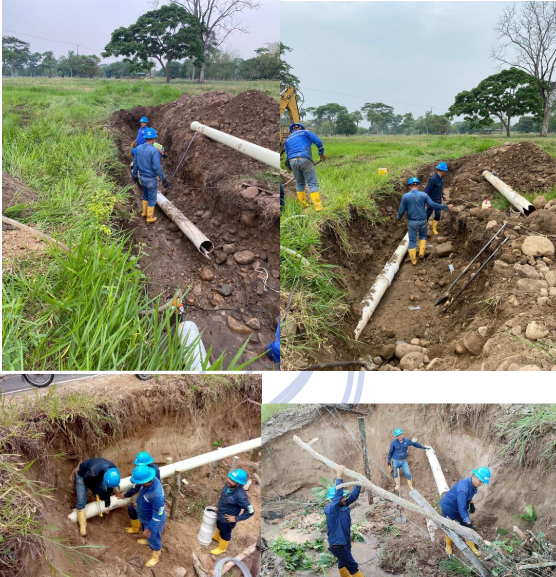
Reparaciones de tubería de conducción
